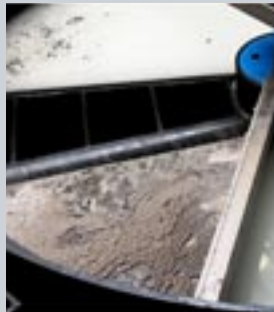
Abscheidung des gebildeten Flockenschlammes mittels VernEx P und Lufteintrag
