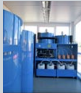
Impianto trattamento acque reflue bistadio
